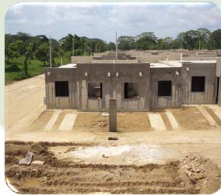
OBRAS SIN TERMINAR
