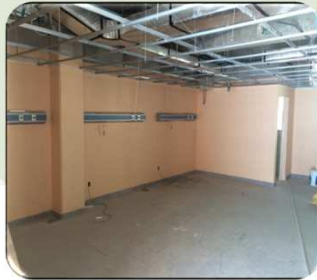
OBRA EN PROCESO
