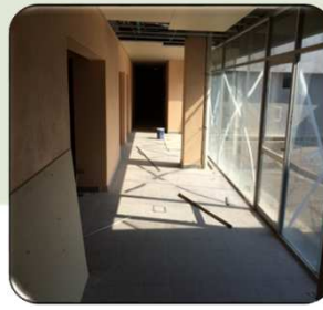
OBRA EN PROCESO
