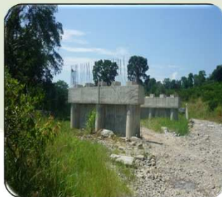
OBRAS SIN TERMINAR
