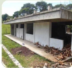
OBRAS SIN TERMINAR
