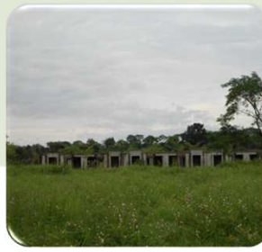
OBRAS SIN TERMINAR
