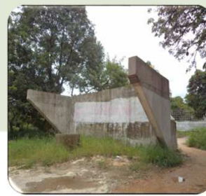
OBRAS SIN TERMINAR
