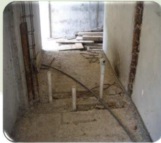
OBRAS SIN TERMINAR
