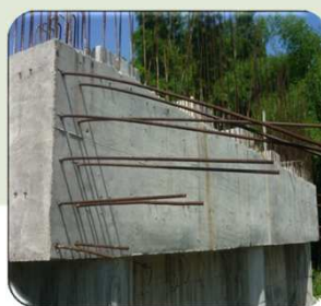
OBRAS SIN TERMINAR
