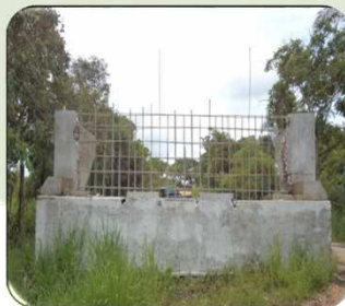
OBRAS SIN TERMINAR
