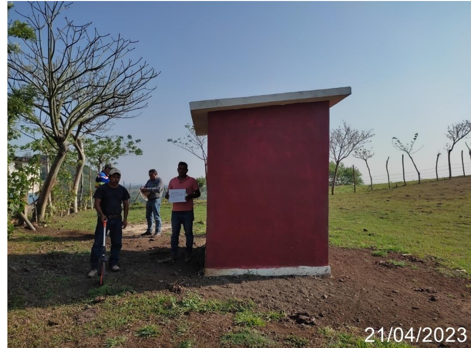
Imagen: Dirección de Auditoría Técnica a la Obra Pública.
