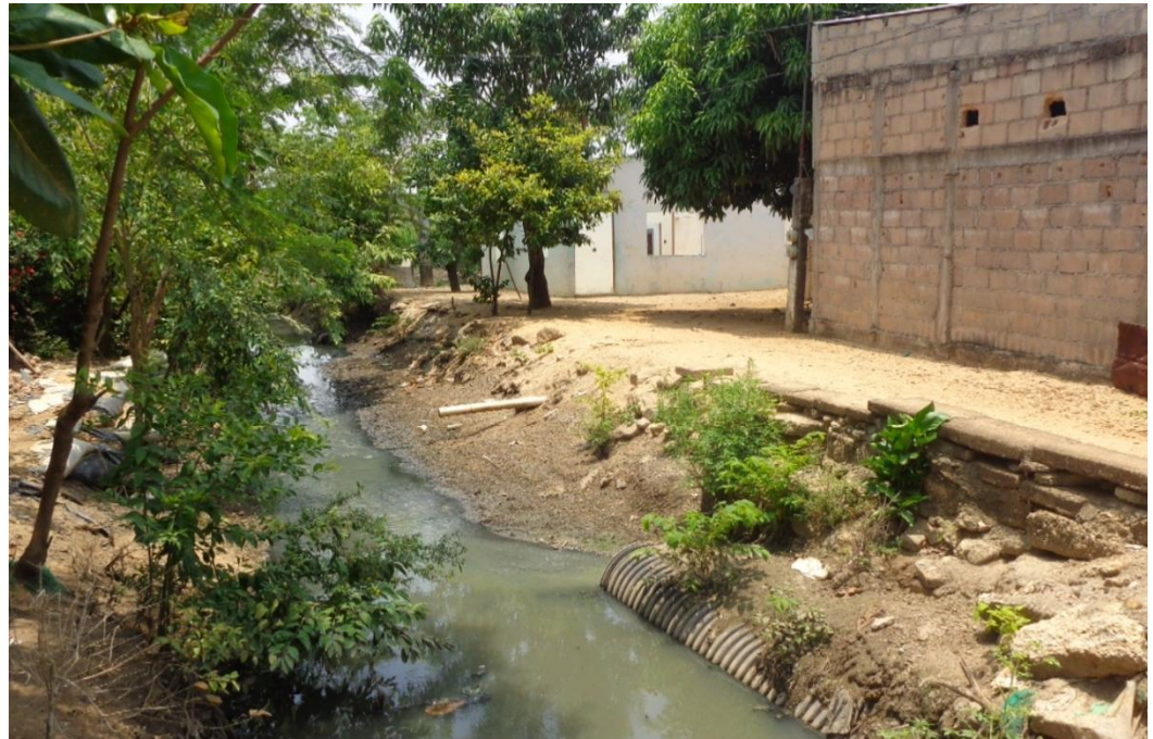
Imagen: Dirección de Auditoría Técnica a la Obra Pública
